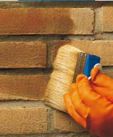
Εφαρμογή του Antipluvioi S με βούρτσα
