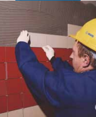
Τοποθέτηση κεραμικών πλακιδίων
